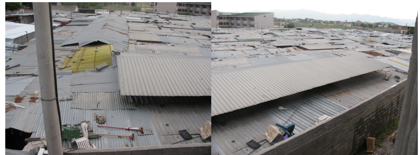
Montažni objekat pijace
