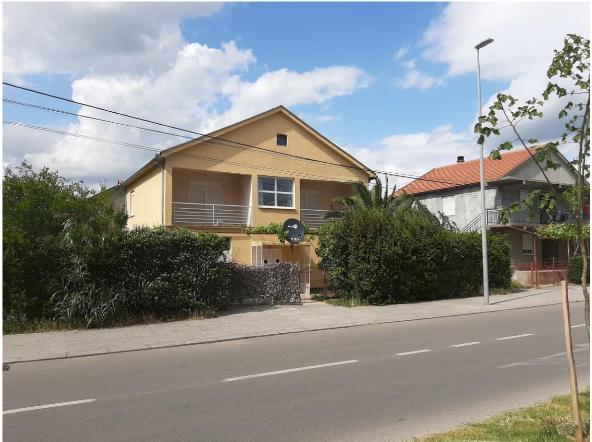
Južna fasada postojećeg objekta
