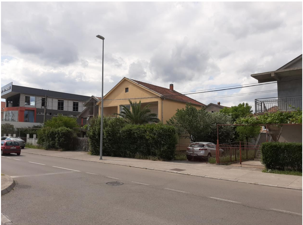
Južna fasada postojećeg objekta
