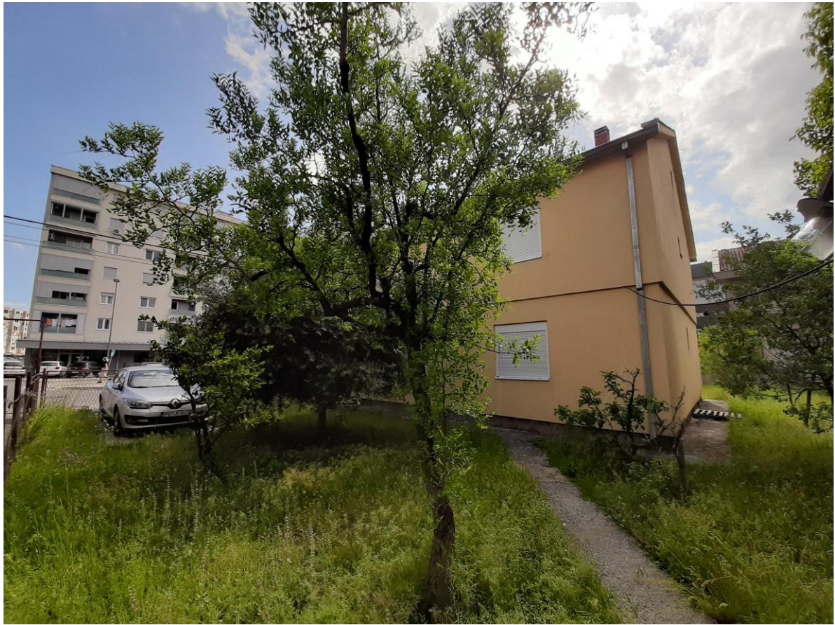
Istočna i sjeverna fasada postojećeg objekta
