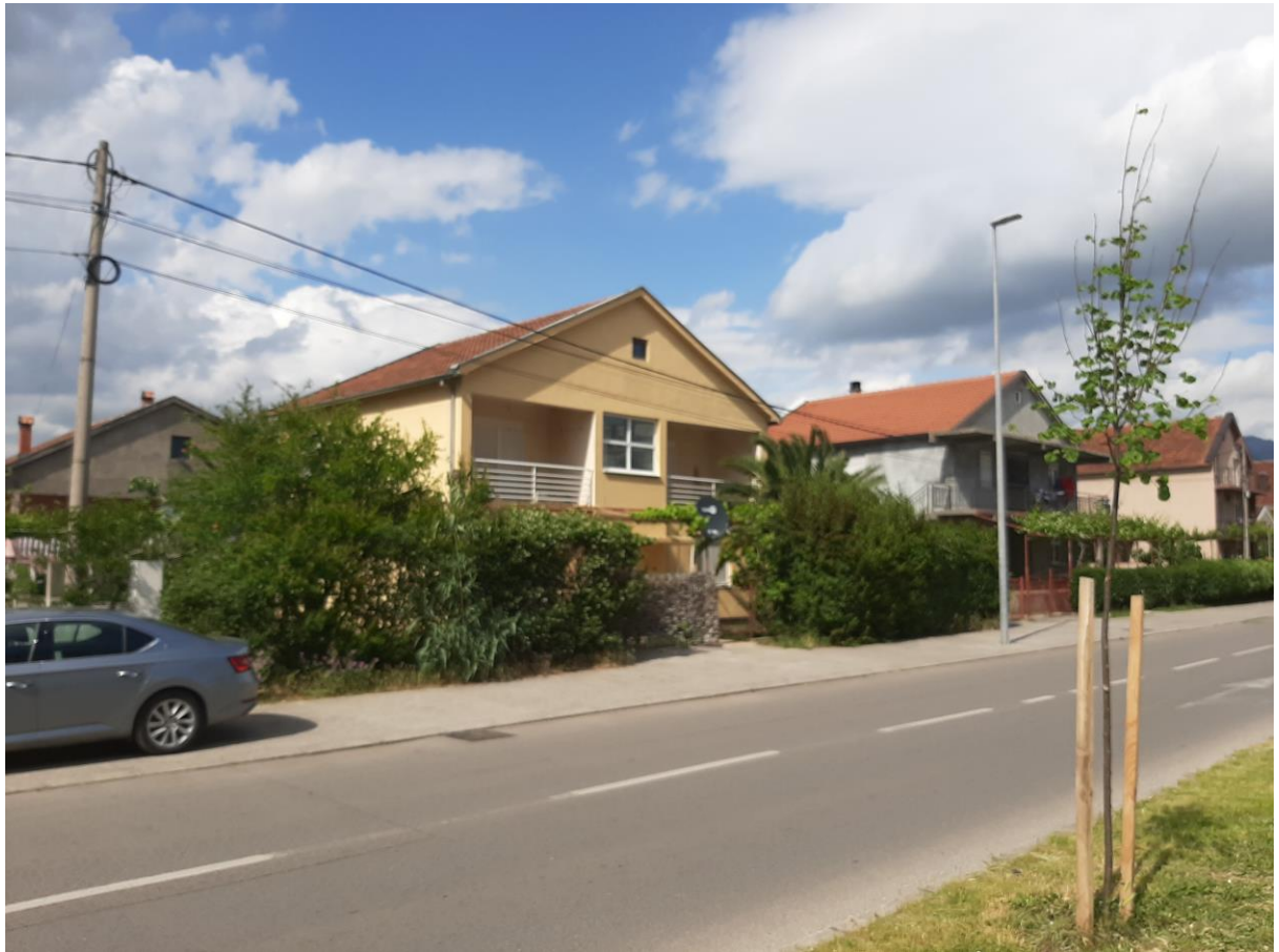
Južna fasada postojećeg objekta
