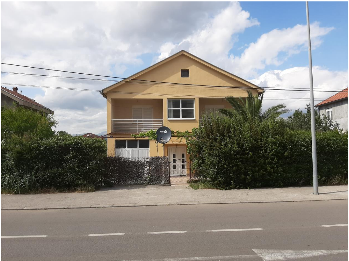
Južna fasada postojećeg objekta
