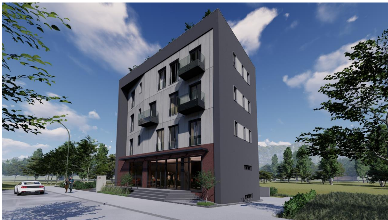
Sl.4. – Pogled na sjevero-zapadnu fasadu
