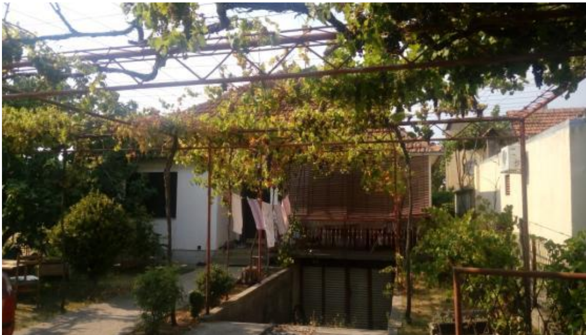
SI1. Postojeći objekat sa podrumo-pogled iz dvorista
