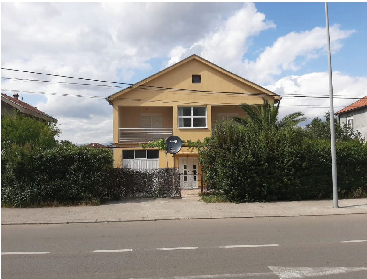
Južna fasada postojećeg objekta
