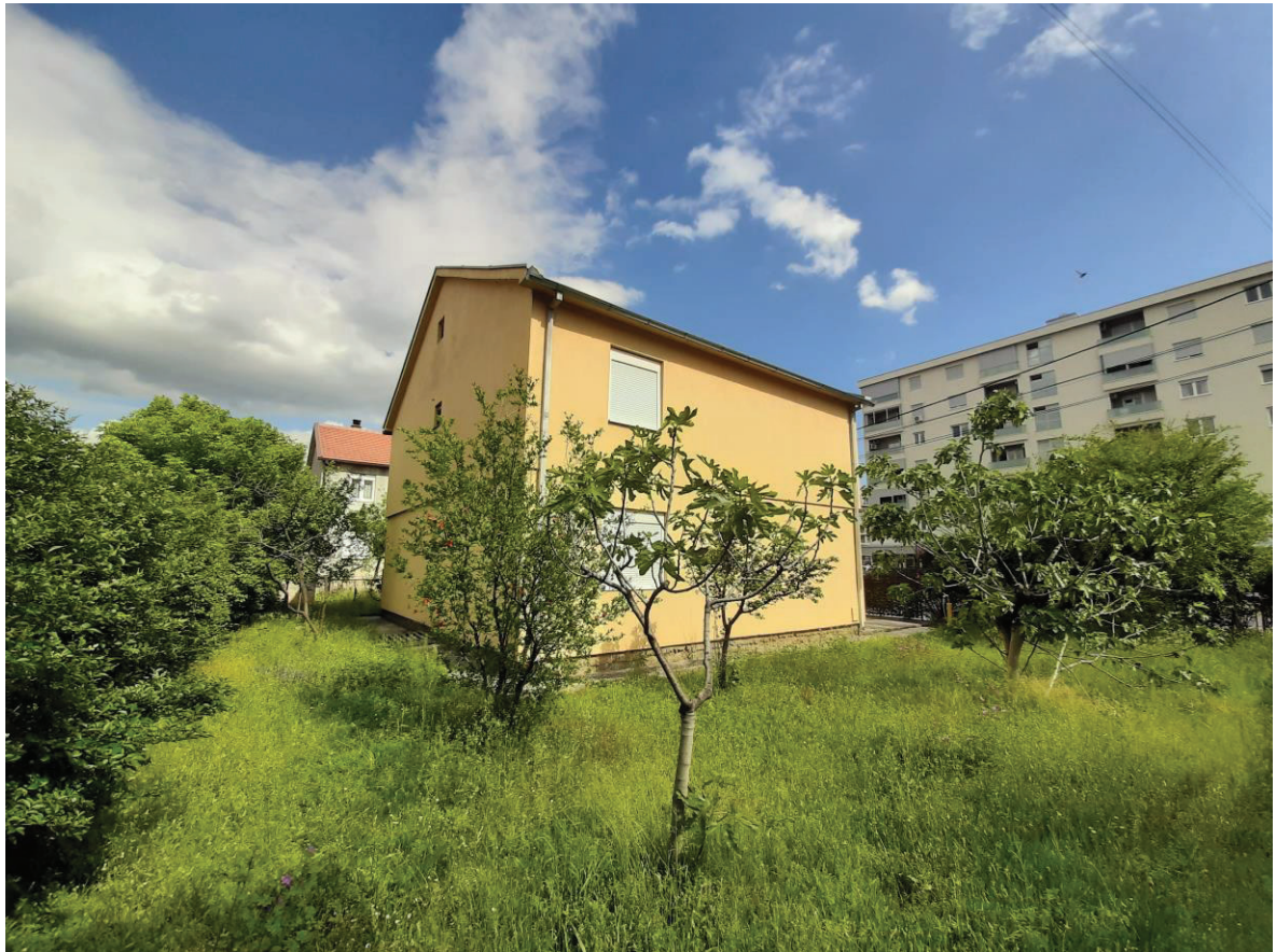
Sjeverna i zapadna fasada postojećeg objekta
