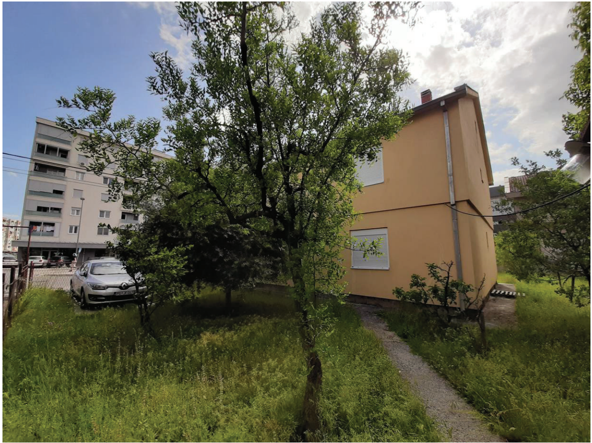
Istočna i sjeverna fasada postojećeg objekta
