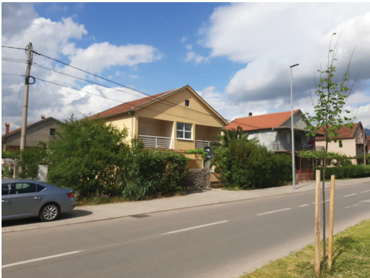
Južna fasada postojećeg objekta
