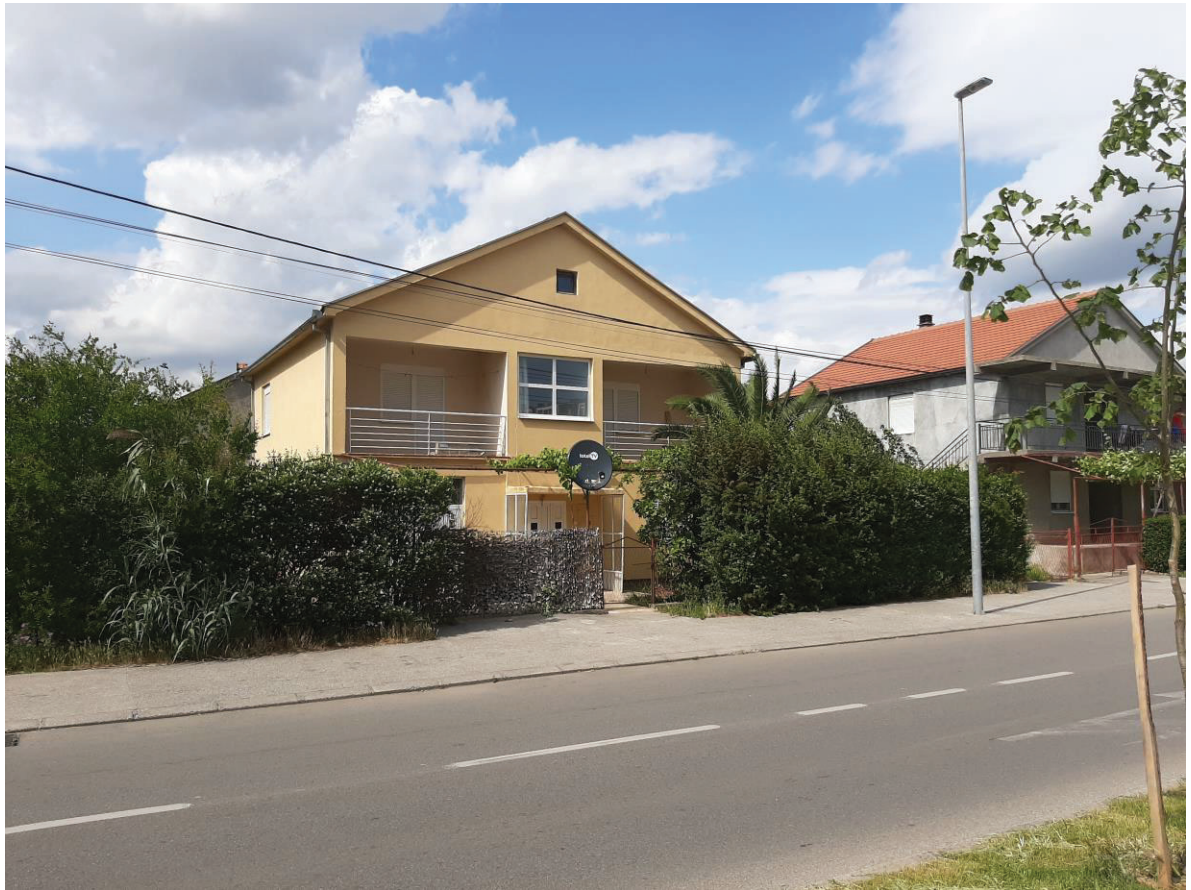
Južna fasada postojećeg objekta
