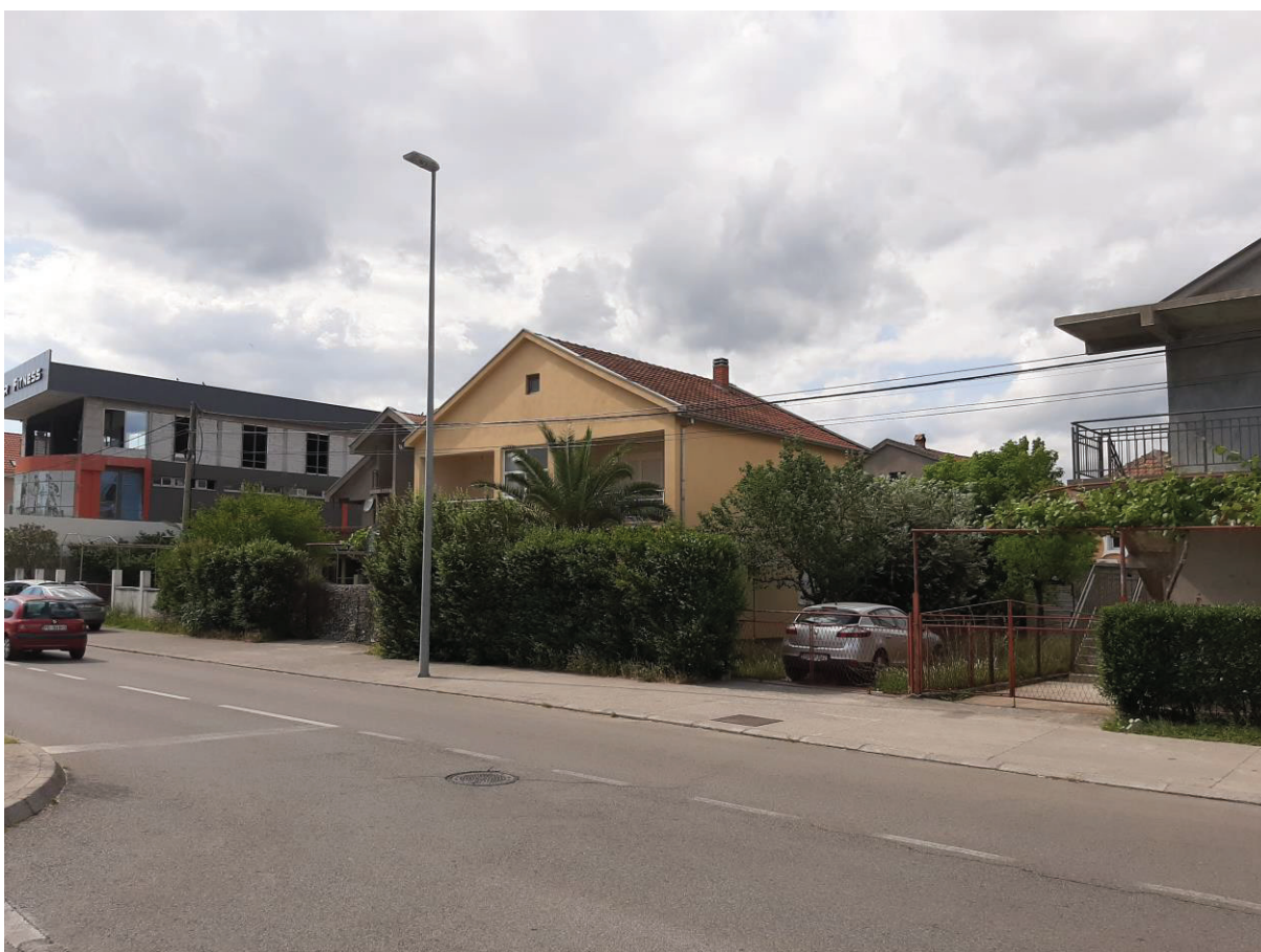
Južna fasada postojećeg objekta
