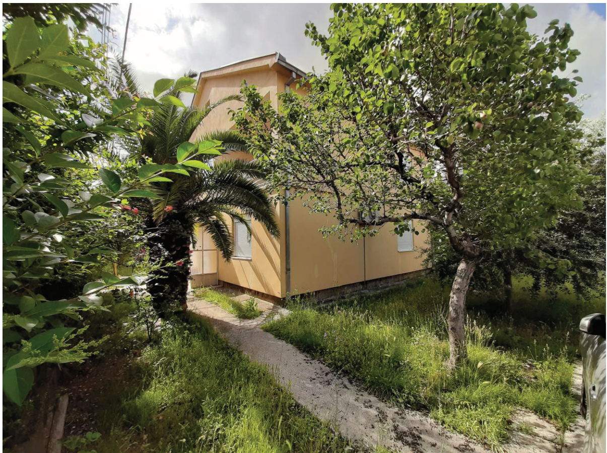
Istočna i južna fasada postojećeg objekta
