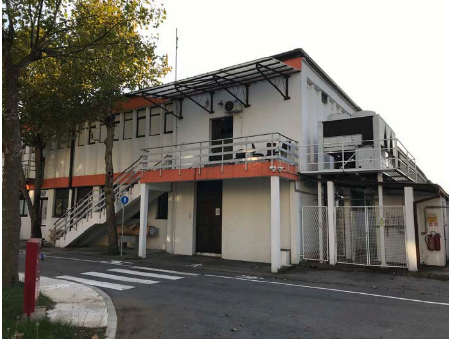
Postojeća fasada objekta koji je predmet rekonstrukcije
