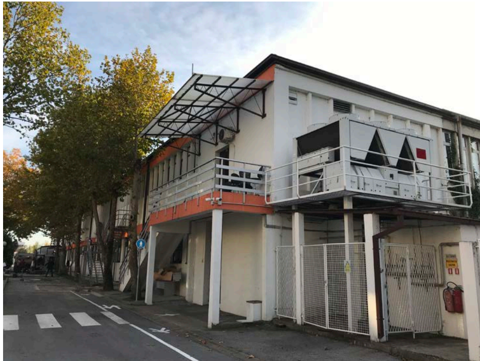
Postojeća bočna fasada objekta koji je predmet rekonstrukcije
