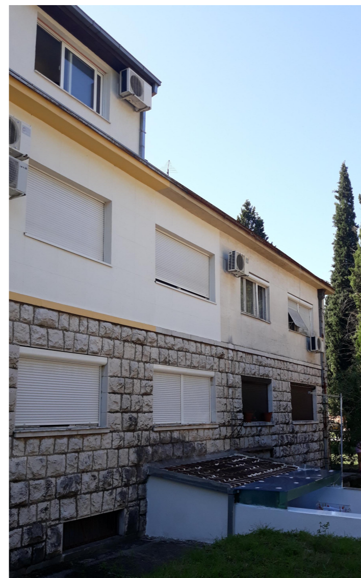
FOTO 02a. POSTOJEĆE STANJE
