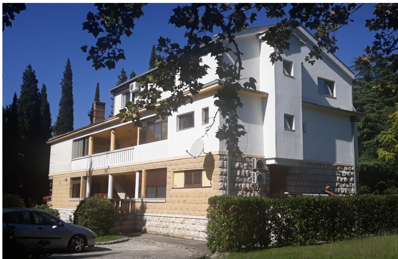
FOTO 01a. POSTOJEĆE STANJE
