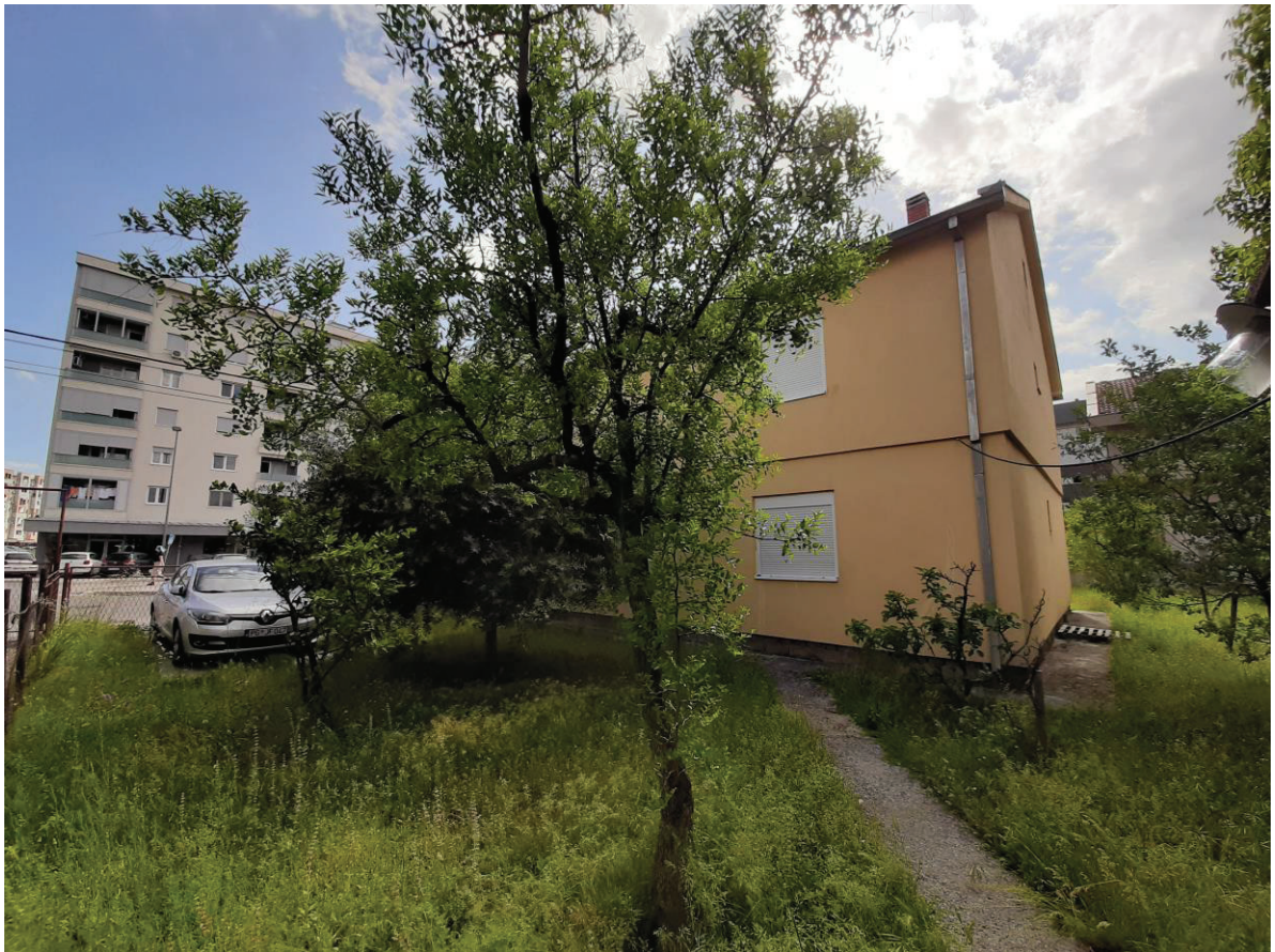
Istočna i sjeverna fasada postojećeg objekta
