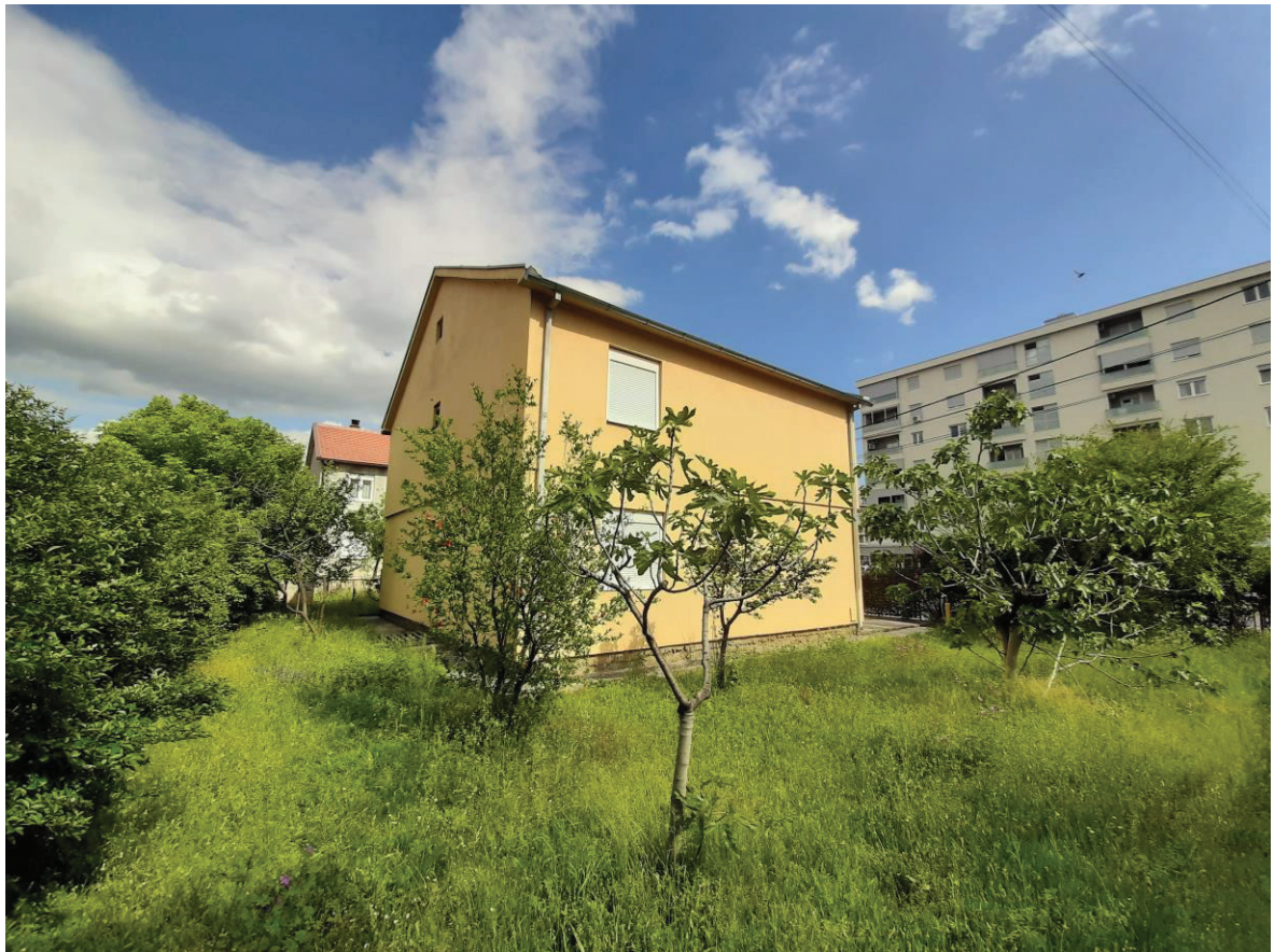
Sjeverna i zapadna fasada postojećeg objekta
