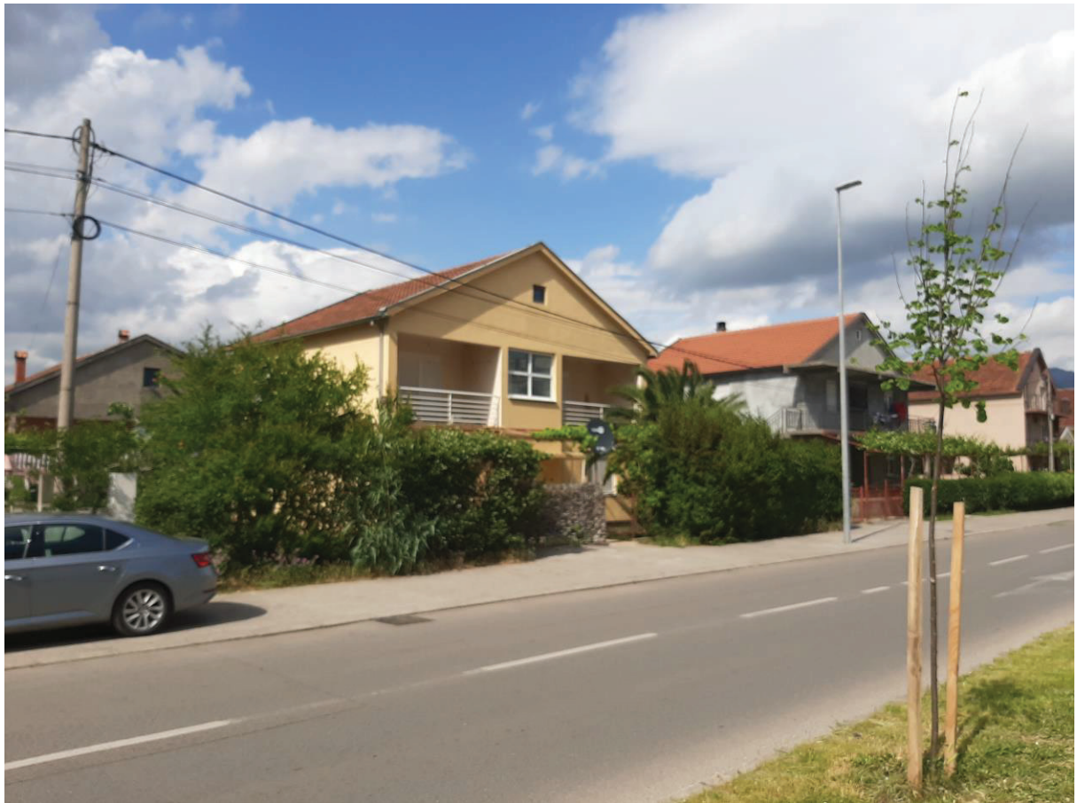
Južna fasada postojećeg objekta
