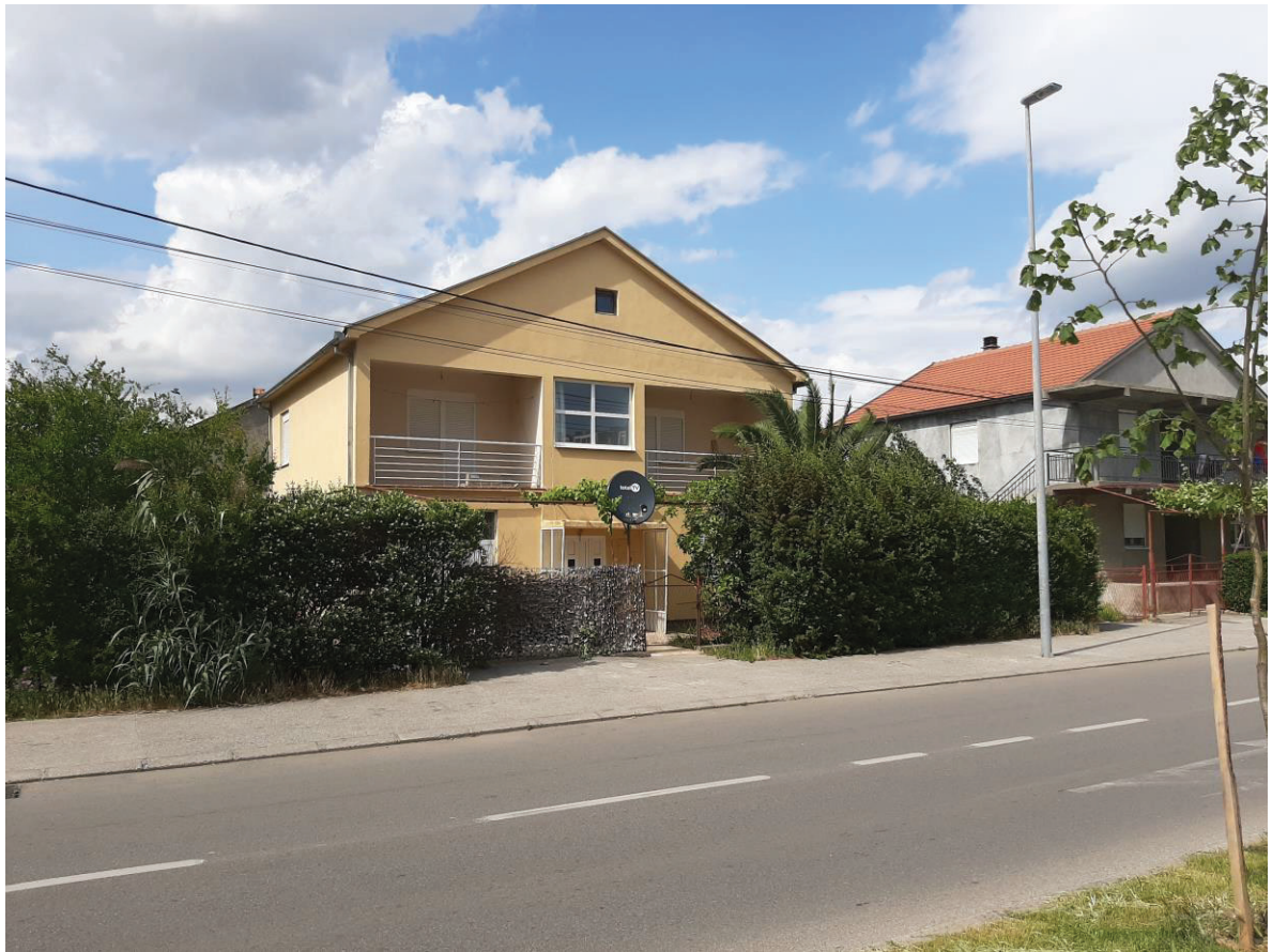
Južna fasada postojećeg objekta
