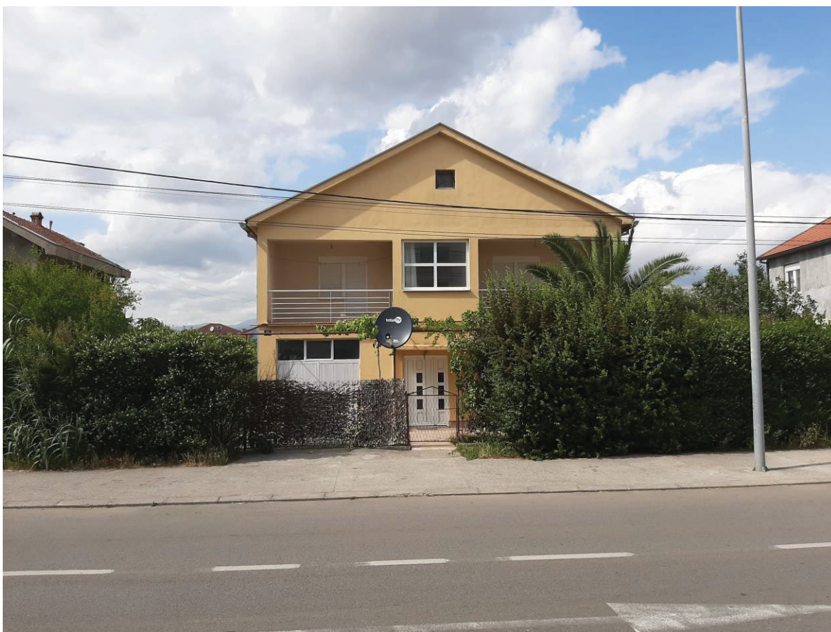
Južna fasada postojećeg objekta
