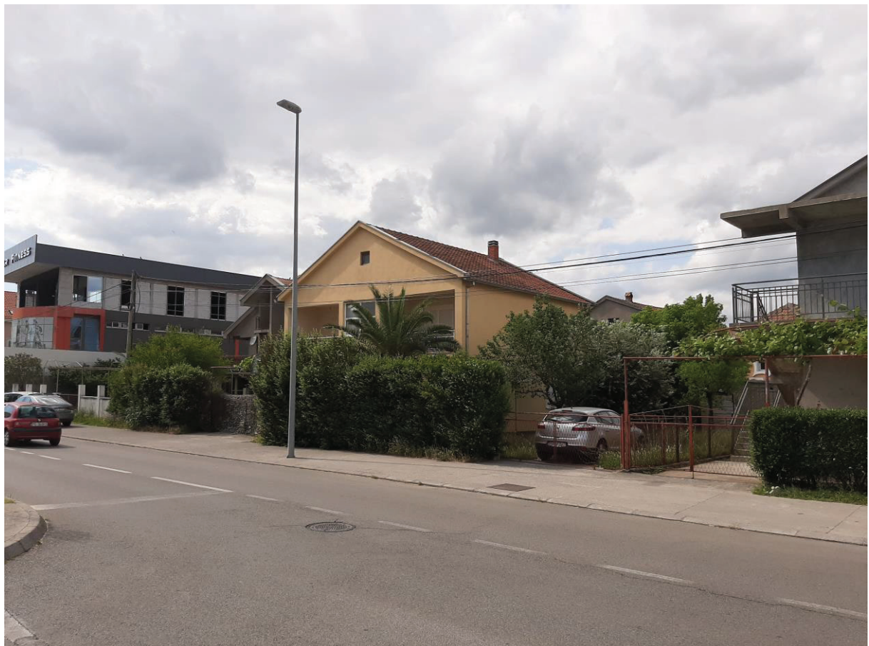
Južna fasada postojećeg objekta
