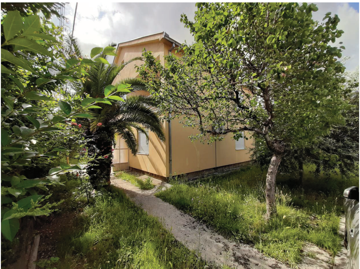
Istočna i južna fasada postojećeg objekta
