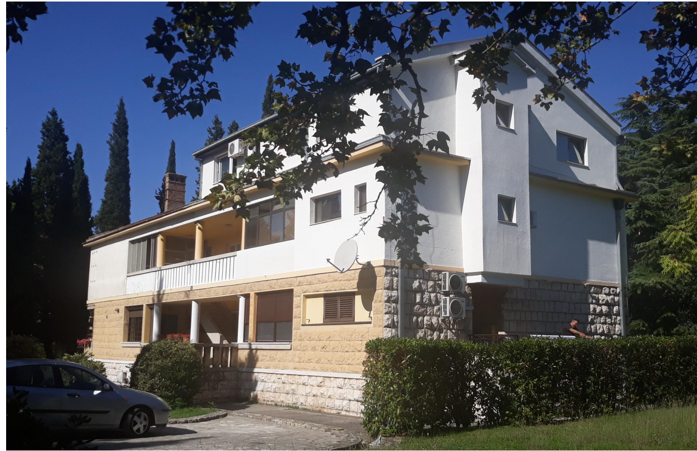
FOTO 01a. POSTOJEĆE STANJE
