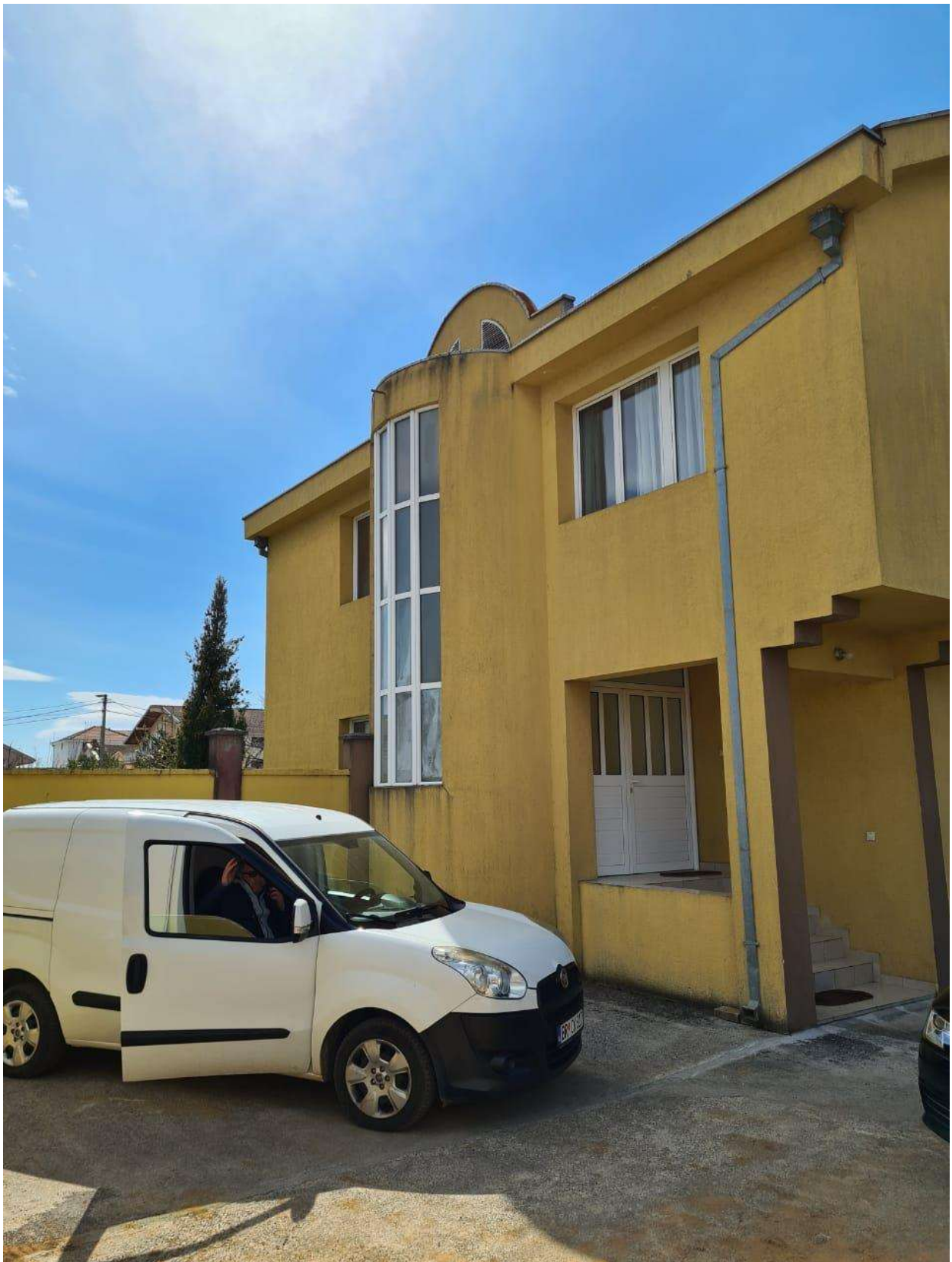
Prilog 3 - Postojeće stanje objekta i lokacije – foto elaborat
