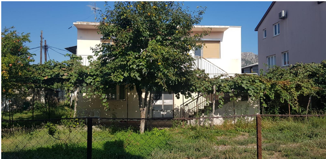
Sl. 1. Postojeći objekat.
