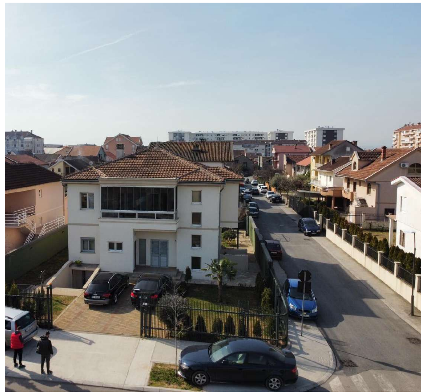
snimak dronom postojeće stanje pogled sjever
