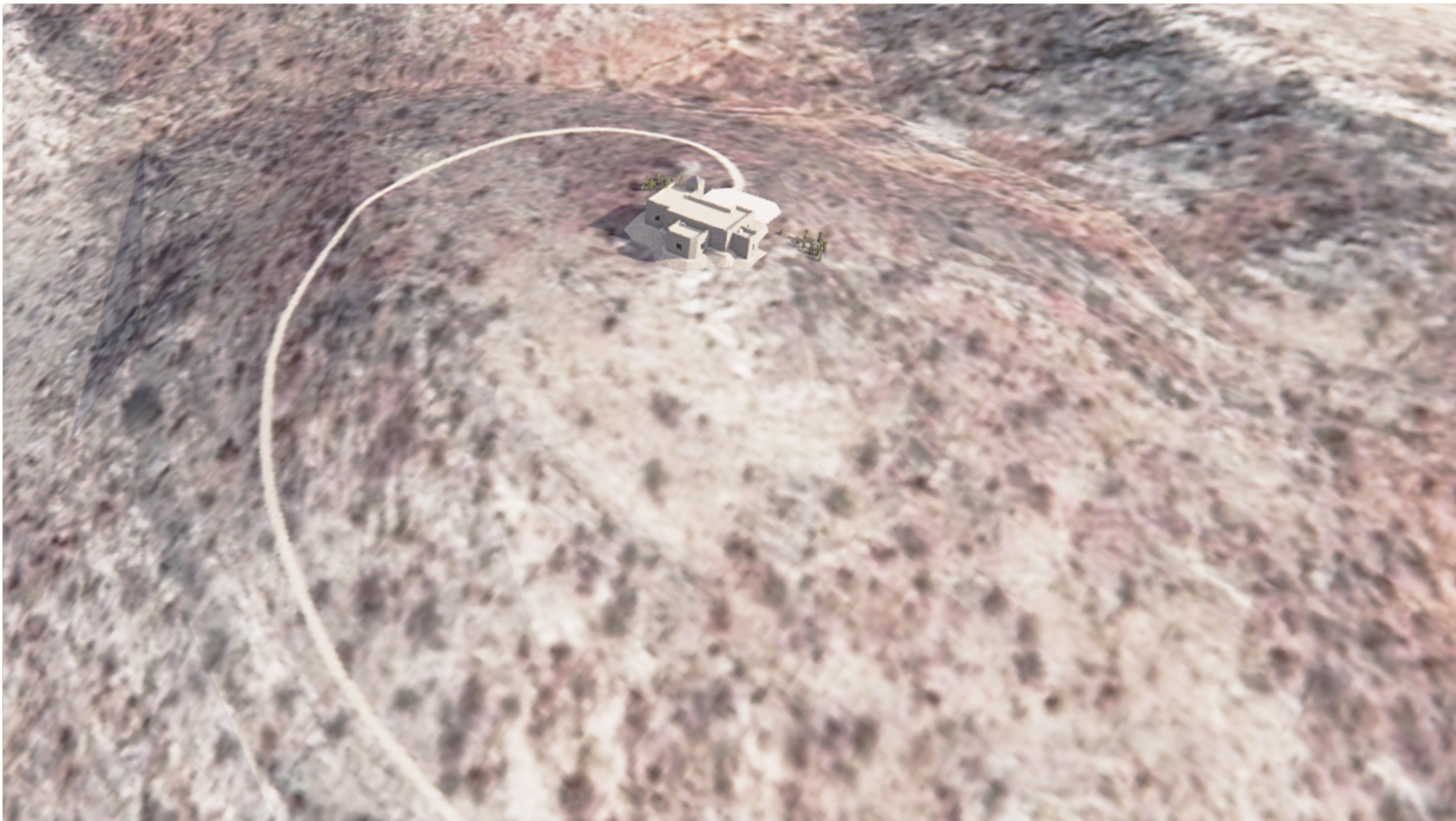
Lokalni objekat od opšteg interesa - objekat za skladištenje poljoprivrednih proizvoda na KP741/2 KO Progonovići u PUP-u Opštine Podgorica, Opština Podgorica
