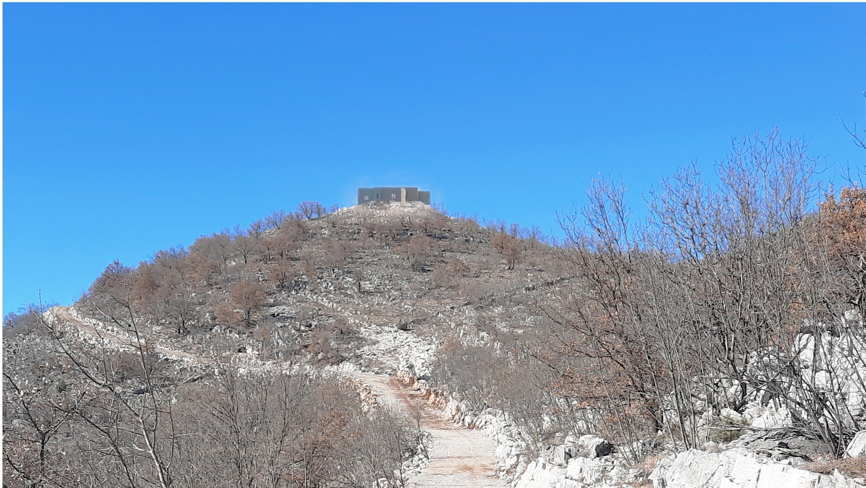
Lokalni objekat od opšteg interesa - objekat za skladištenje poljoprivrednih proizvoda na KP741/2 KO Progonovići u PUP-u Opštine Podgorica, Opština Podgorica
