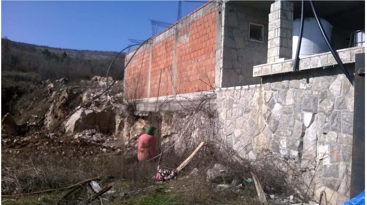
Sika 2: Bočni izgled postojećeg objekta PD3
