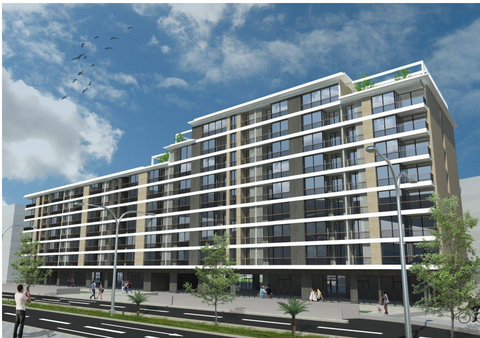
FASADA OBJEKTA PREMA CETINJSKOM BULEVARU
