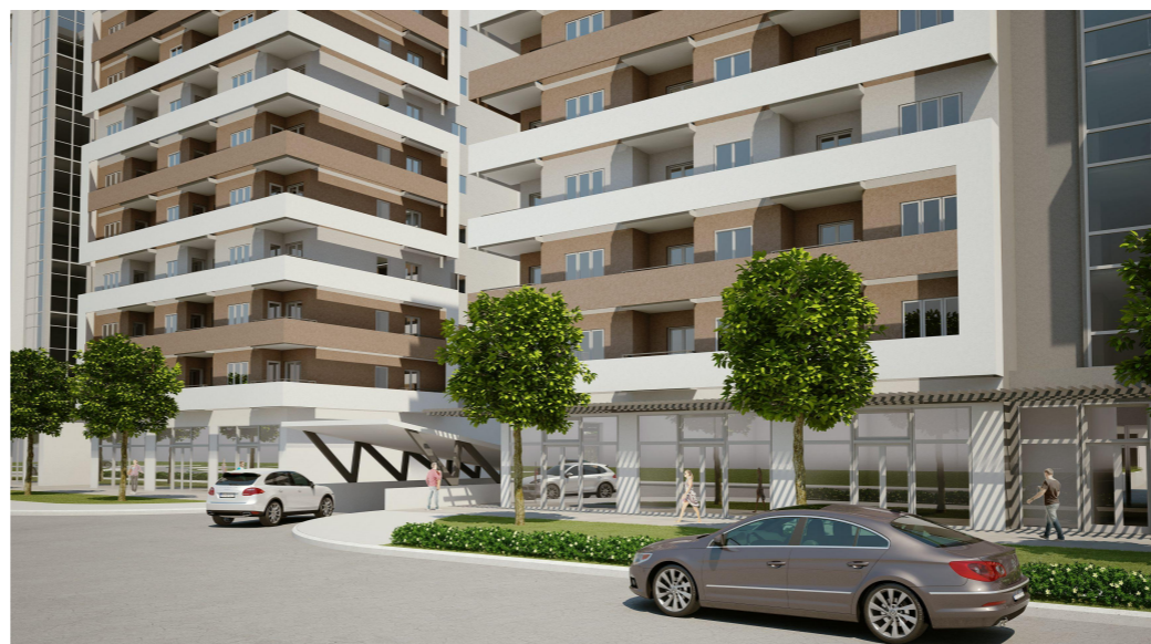
PRILAZ RAMPI - ULICA MARKA RADOVIĆA
